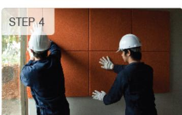
ติดตั้งแผ่นวัสดุอะคริลิก เอสซีจี สำหรับผนังตกแต่งดูดซับเสียง รุ่น Cylence™ Zandera™ จนเต็มพื้นที่ที่ต้องการ และตรวจสอบความเรียบเรียบ พร้อมเก็บรายละเอียดของงาน
