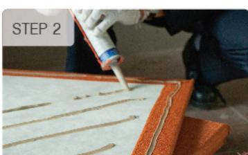
เตรียมแผ่นวัสดุอะคริลิก เอสซีจี สำหรับผนังตกแต่งดูดซับเสียง รุ่น Cylence™ Zandera™ โดยหากาว (กาวตะปู) บริเวณด้านหลังของแผ่น เป็นมุมทแยง ให้เต็มแผ่น
