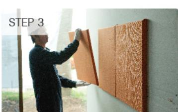
นำแผ่นวัสดุอะคริลิก เอสซีจี สำหรับผนังตกแต่งดูดซับเสียง รุ่น Cylence™ Zandera™ ที่ทำการมาติดตั้ง เช้ากับผนังที่ได้รีบมไว้ โดยกดตึงไว้ประมาณ 1-3 นาที ให้การเข้าทัวร์ดีติดกับผนังจนแน่น ควรเริ่มติดตั้งจากตรงกลางของแผ่นด้านล่างขึ้นไปด้านบน
