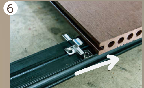
แผ่นต่อไปใช้คลิปต่อระหว่างแผ่นสอดปลายด้านหนึ่ง เข้าใต้แผ่นไม้พื้น
